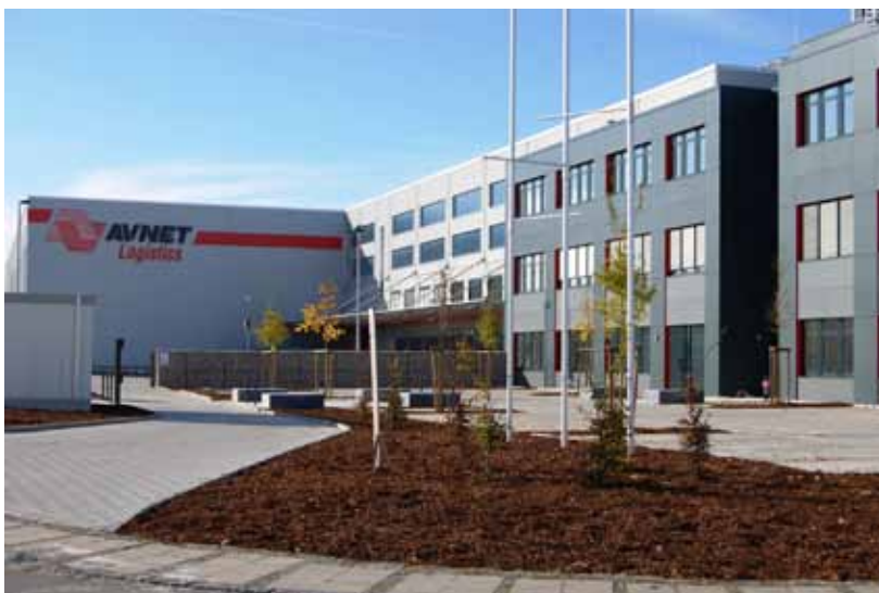
Novo armazém automatizado da Avnet em Poing, Alemanha.
